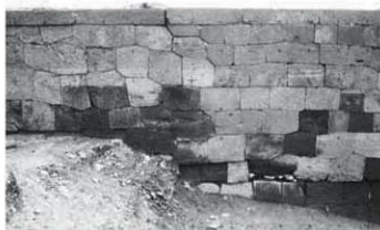
チ・ワ面10 (五十間長屋南半西面 2120W)
