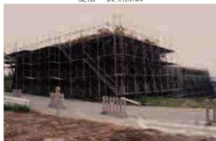
槽（長屋）台足場設置 南から
