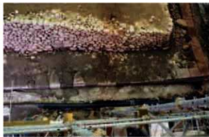
橋爪門統槽台石積遺構 1 南面東側・ 文化期修築作業面
