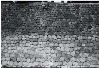
口面2 (五十間長屋南半東面 2120E)
