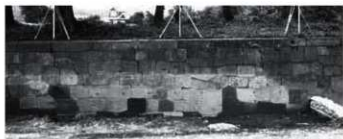
チ・ワ面9 (五十間長屋南半西面 2120W)
