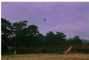
測量作業風景
