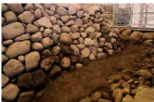
橋爪門続槽台石積遺構1 東面北側・ 文化期修築作業面
