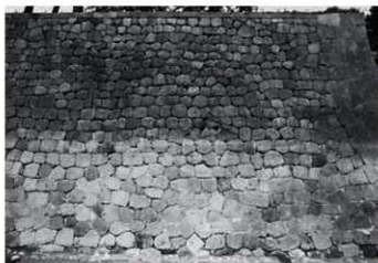
口面 6 (五十間長屋南半東面 2120E)
