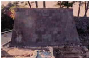
橋爪門続槽台石垣東面 (2110E)
