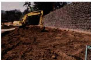
内堀中央部 表土除去 東から
