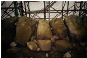
口面 (2120E・宝暦期修築) 1533付近押石
