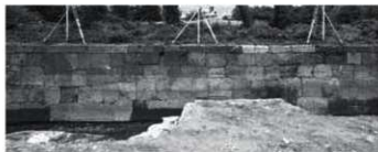
チ・ワ面2 (五十間長屋南半西面 2120W)
