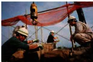
石垣解体作業風景
