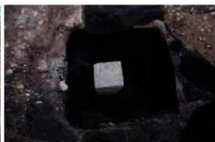
橋爪一ノ門 P1 控柱礎盤 (根石) 南から
