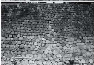
口面4 (五十間長屋南半東面 2120E)
