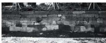
チ・ワ面7 (五十間長屋南半西面 2120W)
