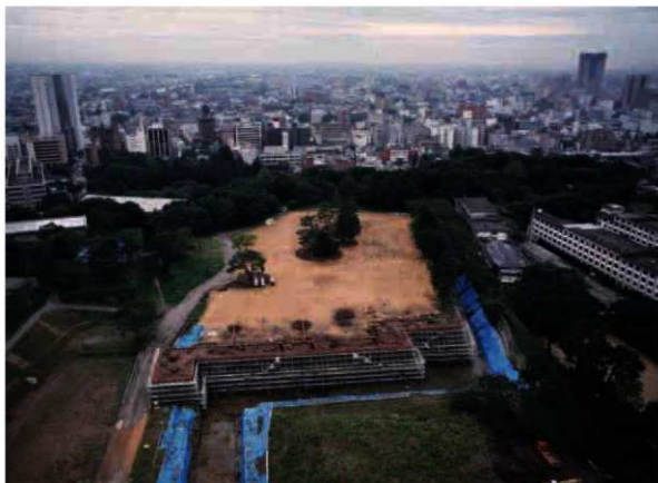
菱槽・五十間長屋・橋爪門統槽台 遠景 東から
