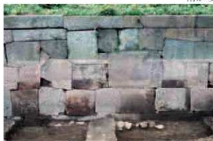
櫓（長屋）台取付階段③ 五十間長屋(南側南北部) 西から
