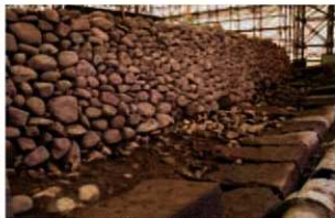
橋爪門統槽台石積遺構 1 南面・ 寛永期石垣裏込上面
