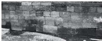
チ・ワ面3 (五十間長屋南半西面 2120W)
