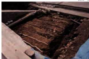
二ノ丸階段 北から
