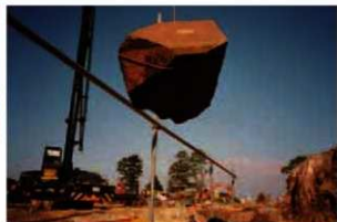
石垣解体作業風景
