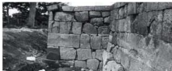
ル面 (菱槽南面 2140S)
