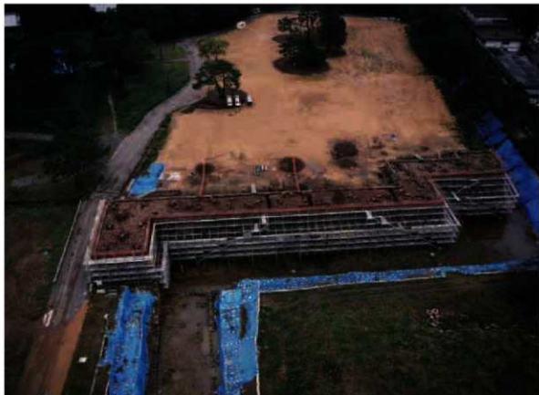
菱槽・五十間長屋・橋爪門続槽台 全景 東から
