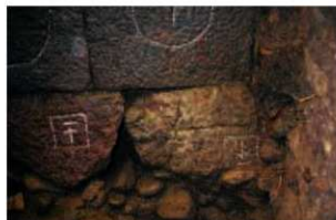
五十間長屋台石垣西面 (才面2120W) 下部 SP9付近 根石確認トレンチ北
