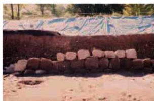
内堀東部南岸（鶴ノ丸北面石垣 2110N） 4
