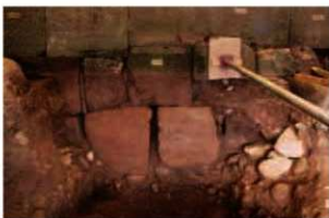
橋爪門続槽台石垣東面 (才面2110E) 下部 根石確認トレンチ
