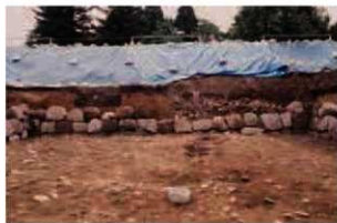
内堀東部東岸（南門土橋石垣西面 2230W）
