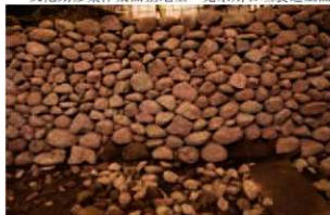
橋爪門統槽台石積遺構 1 南面中央・ 寛永期石垣裏込上面
