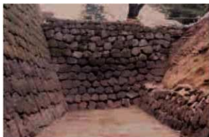
裏口門土橋石垣東面 (2210E)
