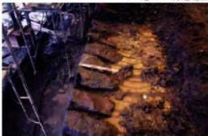
五十間長屋台石垣東面（口面2120E）根石 SP9付近 北から
