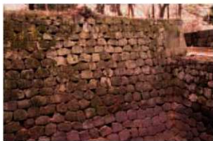
二ノ丸北面石垣 (2140N) 西端、裏口門付近
