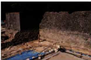
五十間長屋台石垣東面～橋爪門続槽台石垣北面 (2120E_2110N)
