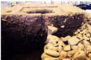
橋爪門統槽台東西土層断面 SP12 L=45.4_44.5m付近北壁(石積遺構 2)
