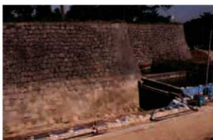
五十間長屋台石垣と水槽 ST8 遠景 東から
