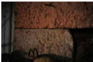
ト面 (2110S・文化期修築) 12・13の合場
