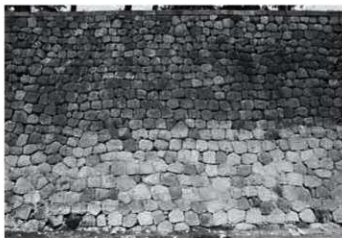
口面 5 (五十間長屋南半東面 2120E)
