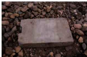
五十間長屋 古段階礎盤(根石)ウ 上面 西から
