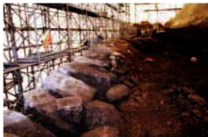
石垣解体作業風景
