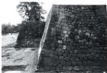
水面（菱櫓北面 2140N） 八面（五十間長屋北半北面 2130N）
