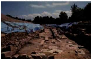
内堀東部 掘削作業
