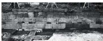
チ・ワ面6 (五十間長屋南半西面 2120W)
