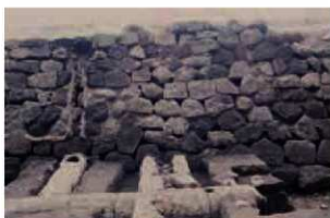
近代石垣 SW2 西から
