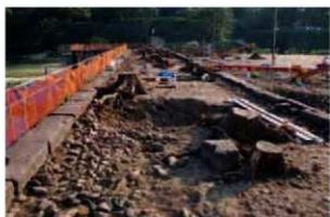
五十間長屋 作業風景 北から
