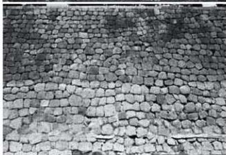
口面3 (五十間長屋南半東面 2120E)
