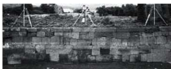
チ・ワ面5 (五十間長屋南半西面 2120W)
