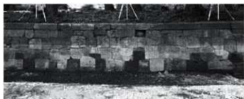
チ・ワ面8 (五十間長屋南半西面 2120W)
