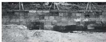
チ・ワ面4 (五十間長屋南半西面 2120W)
