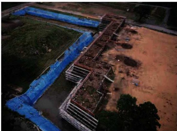
菱槽・五十間長屋・橋爪門続槽台 全景 北西から
