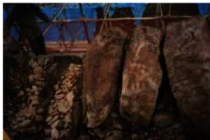
ホ面 (2140N・寛文期修築) 石垣解体作業
