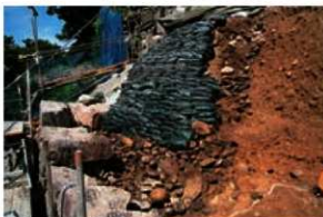
Eトレンチ 第3・5群(掘方2・4)
