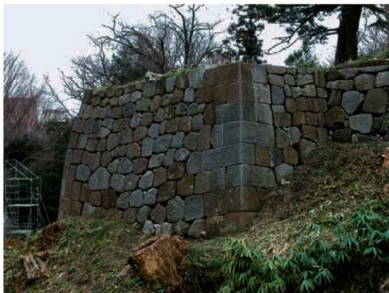
B・C面 調査着手前（平成15年）
