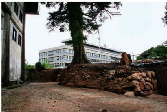
東側法面 全景
