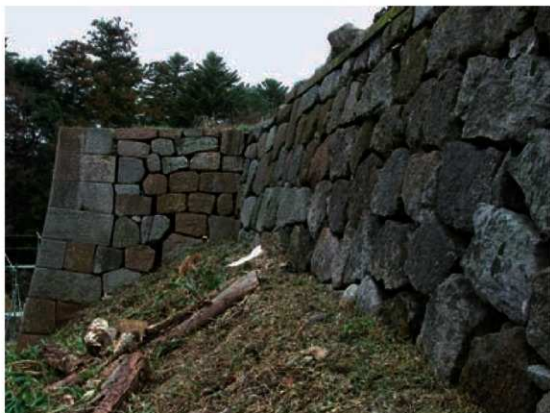
A・B面 調査着手前（平成15年）
