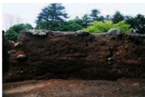
断面No.22 東側法面 1
