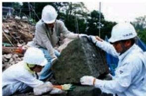
石材取り外し
