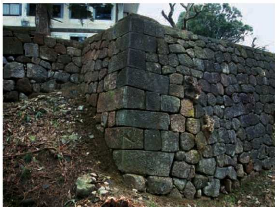
E・F面 調査着手前（平成15年）
