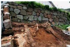
断面No.8・9 B面スノ 全景
