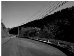
遠景 (北西から)
