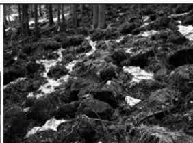
転石等の堆積状況
