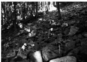
B 地区石材清掃作業 (西から)
