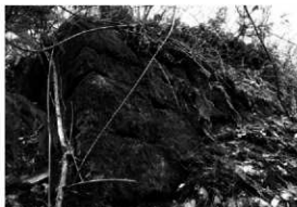
採掘坑群前面の平坦面に伴う石垣
