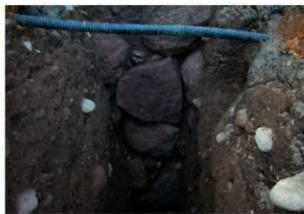
2002-15地点 石垣立面(1241E)
