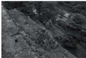
丑寅槽東側の石垣・平坦面
