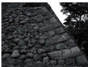
辰巳櫓下石垣 (下段1140S2、上段は近代の改修)
