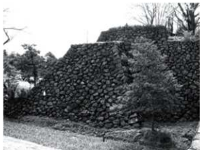
丑寅槽（東ノ丸）北面（1121N）
