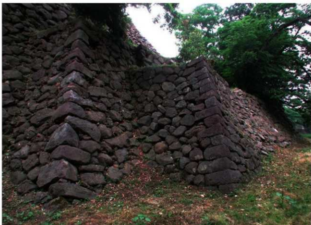
2002-21地点付近 調査着手前
