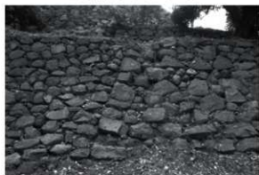
丑寅槽東側石垣（下段から1220E、1210E、1121E）
