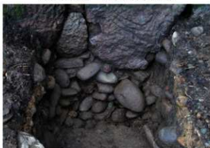
2002-34・35地点(西) 石垣(1300N)基礎
