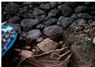
2002-12地点 石垣立面(1121E)
