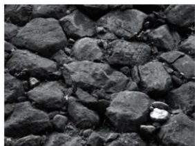
東ノ丸東面石垣 (1131E) 近景
