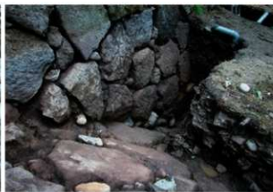
2002-5地点 石垣立面(1710E)
