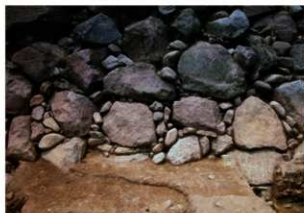
2003-2地点 石垣立面(1121E)
