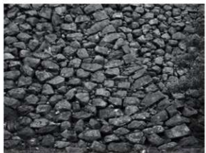
丑寅櫓（東ノ丸）北面（1121N）西
