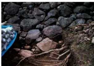
2002-12地点 石垣立面(1121E)
