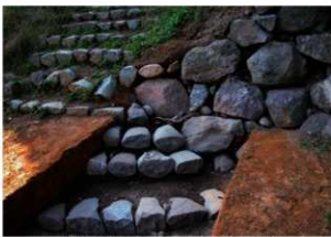
2002-19地点 石垣立面(1241E)
