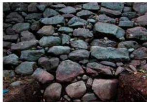
2002-18地点 石垣立面(1220E)
