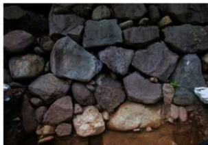
2002-10地点 石垣立面(1210E)
