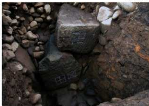
2003-6地点 石垣立面(1421W)
