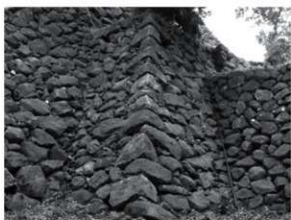
丑寅櫓東側石垣（左から1131E、1200S・E、1220S）
