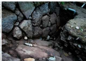
2002-5地点 石垣立面(1710E)
