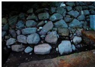
2002-17地点 石垣立面(1220E・1221E)
