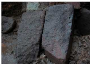
2002-34・35地点 第Ⅱ段階側壁石垣
