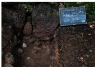
2002-34・35地点(西) 石垣立面(1300N)
