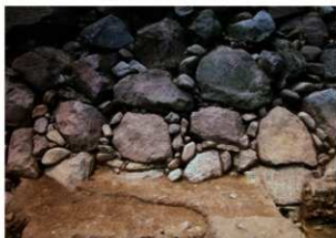
2003-2地点 石垣立面(1121E)
