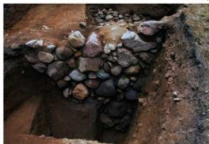
2003-5地点 石垣立面(1803W)
