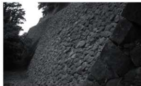
東ノ丸東面石垣（上段1130E、下段1131E 右手前1200E）
