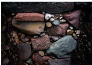
2004-7地点 石垣立面(1352W)
