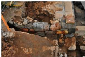
4区 三ノ丸東水ノ手門北石垣① 西から
