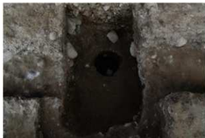
3区-35 控柱拔取痕完掘状況 南から
