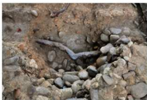
3区-33 コンクリート製控柱掘方完掘状況 東から
