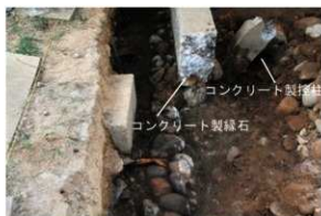
コンクリート製控柱・緑石解体中 南から
