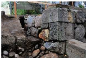
4区 三ノ丸東水ノ手門北石垣② 南から
