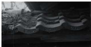
昭和保存修理工事前の屋根瓦
