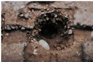
5区-66 控柱拔取痕完掘状況 西から
