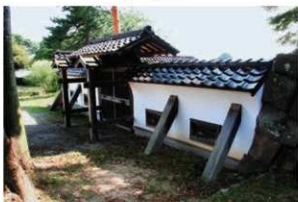
5区 水ノ手門 南から
