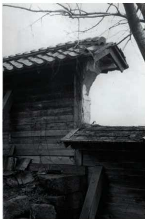
⑥三ノ丸東石垣 塀上下の取付き
