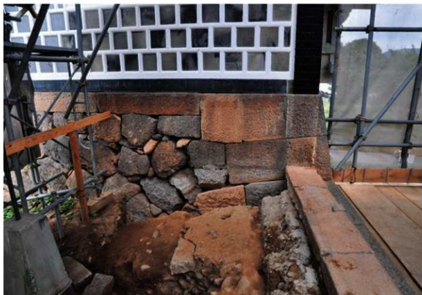
1区 石川門続櫓台石垣 南から
