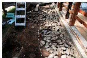
昭和保存修理以降の修理痕跡 東から
