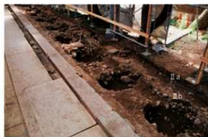
5区 コンクリート製控柱掘方完掘状況 北から
