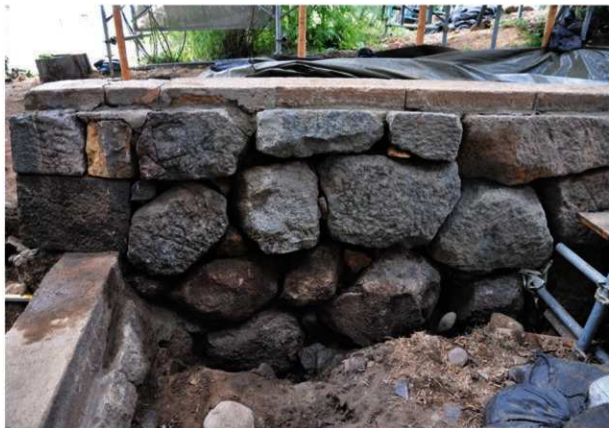
4区 三ノ丸東（太鼓塀下）石垣 南から
