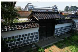
5区 水ノ手門 東から
