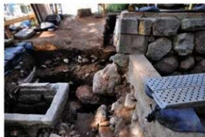
5区 三ノ丸東（太鼓塀下）石垣検出状況① 南から
