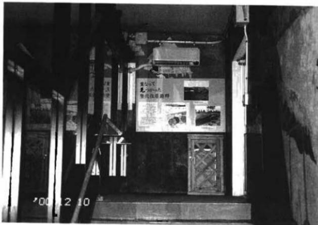
図2. 導入された、除湿器と空調装置
