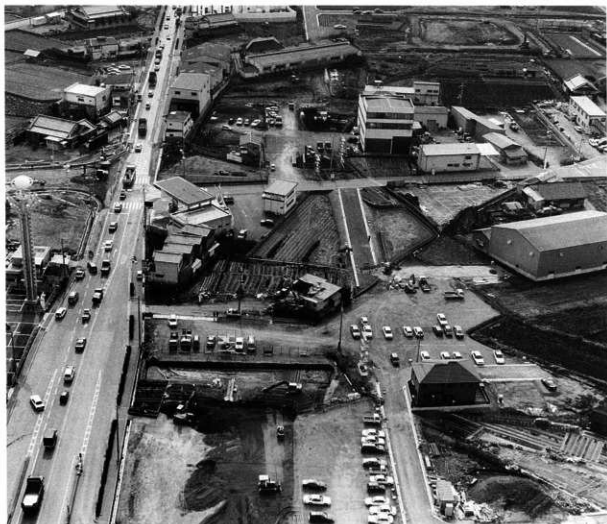
JR線上空側から調査区を望む (北西→南東)
