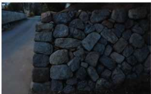
写真 23 復元完了（北面）
