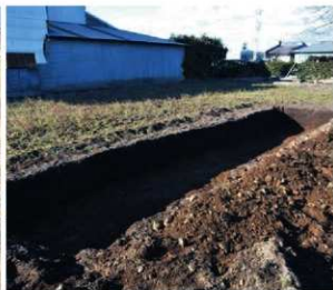
写真82 2T調査状況
