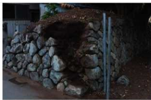
写真7 石取り上げ後状況3
