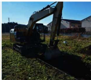
写真74 重機掘削状況
