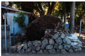
写真15 掘削作業完了状況1
