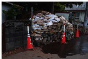
写真 17 応急措置状況
