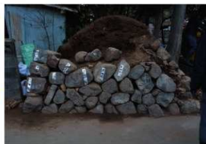
写真 20 復元作業状況 3
