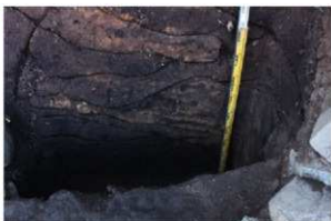
写真12 土手断面 (E-F)2
