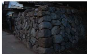
写真 24 復元完了（東・北面）
