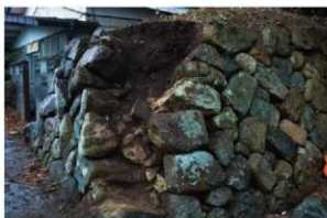
写真5 石取り上げ後状況1
