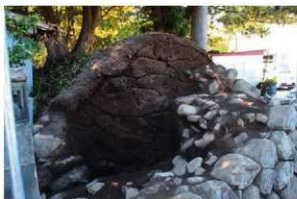
写真11 土手断面 (E-F)1
