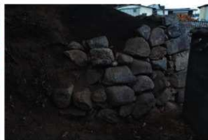
写真 22 復元完了（南面）
