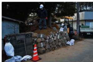
写真 21 復元作業状況 4
