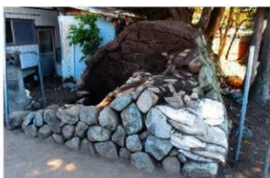
写真16 掘削作業完了状況2
