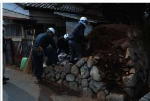
写真 18 復元作業状況 1
