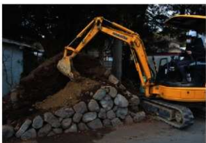
写真 19 復元作業状況 2
