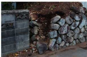
写真6 石取り上げ後状況2
