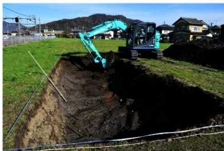
重機掘削状況 (南から)
