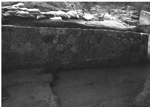
図版 19 第 11 号墓 上：完掘の状況（墓庭石積み） 下：同上
