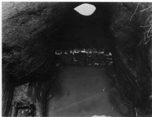
市原市養老藤原式揚水車2号機排水孔
