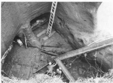
藤原式揚水車 1号機
