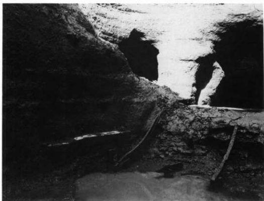
市原市養老藤原式揚水車2号機動力部北側
