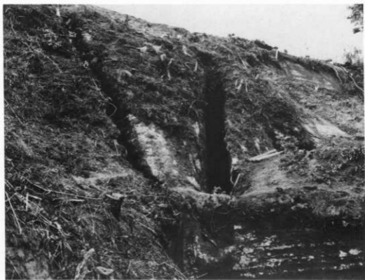
市原市養老藤原式揚水車1号機揚水用施設
