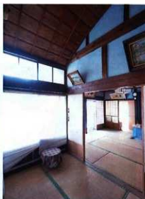
写真16. 曲線を描く吹抜け天井
