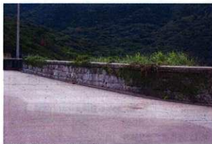
写真 19. 屋久島灯台石塀
