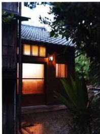
写真 57. 改修後の外観
