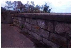
写真 20. 屋久島灯台石塀
