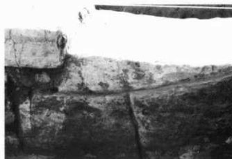
3. 同左側壁 (東から)
