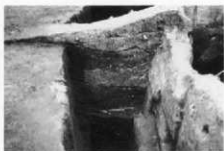
3. 西側壁背後の裏込め
