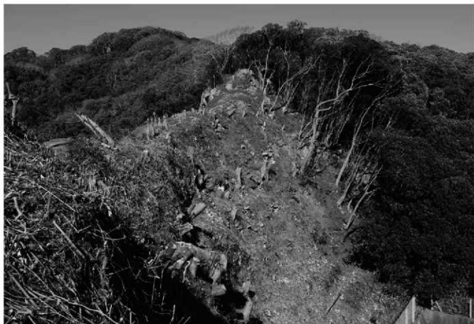
(2) 尾根頂部～東斜面全景 (南から)
