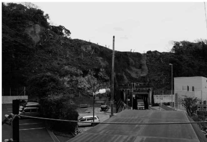
(1) 西斜面全景 (西から)
