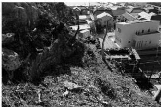
(6) 西斜面上部崩落箇所 (北から)
