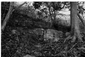
(8) 西谷津北部斜面の石垣 (南西下から)
