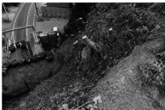
(4) 東斜面整堀状整形 (南東から)
