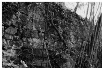
(7) (6) 左下の石垣 (南東から)
