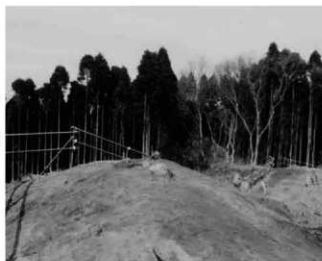
(3) SM-002 北側表土除去後 (西から)
