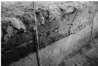
(2) ST-001 内トレンチ A-A' 土層入口寄り
