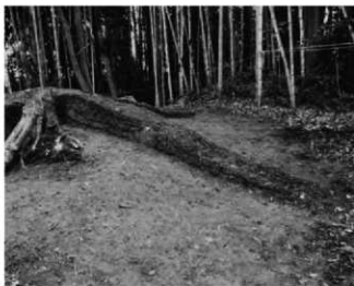
(4) SM-005 盛土状況(2)(北西から)
