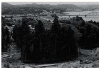
(1) 調査終了後全景(北から)
