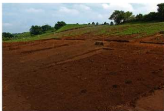
(4) 表土除去後風景
