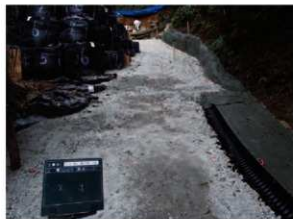
1. 仮設道路建設前(北から) 2. 土木シート敷設(北から) 3. 盛土(南から) 4. 排水管設置(北から) 5. 排水管理設(北から) 6. 吸出防止材敷設(北から) 7. グランドセル設置(北から) 8. 仮設道路竣工(北から)
