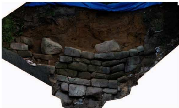
1. 東石塁解体前オルソ画像（北西から）
