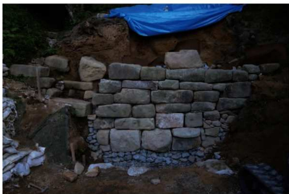
2. 東石塁積み直し完了（北西から）
