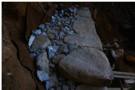
2. 裏込石充填完了(北東から)
