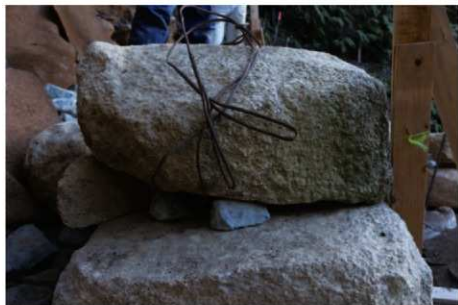
1. 築石据え付け状況 (北東から)
