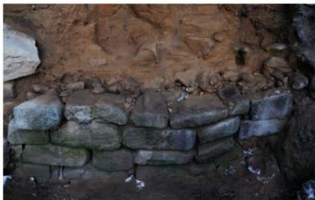
2. 東石塁 2 段目天端① (北西から)
