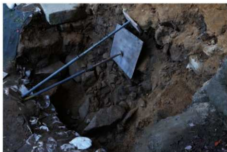
2. 東石墨基礎検出状況 (西から)
