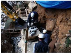
1.裏込補強(北西から) 2.石塁基礎鋼製かご枠設置(北西から) 3.石塁基礎設置完了(北西から) 4.丁張確認(西から) 5.電動工具による補石加工(東から) 6.手作業による補石加工(北から) 7.石塁積み直し(北東から) 8.裏込石充填(南西から)
