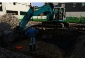
写真 29 西区重機掘削・人力掘削状況
