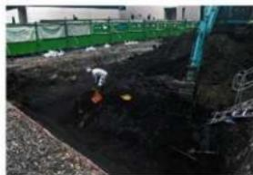
写真20 北区重機掘削・人力掘削状況
