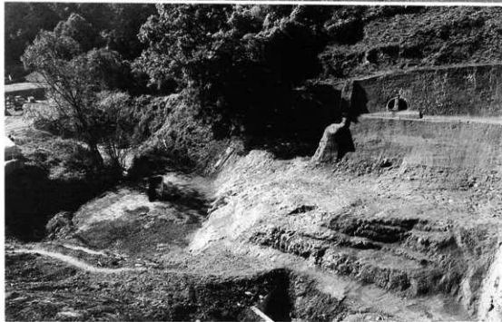
B区南半全景と2-OK (北東から)
