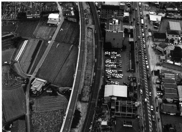
B区(北東から)
