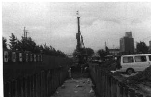
写真2 機械掘削（北西から）
