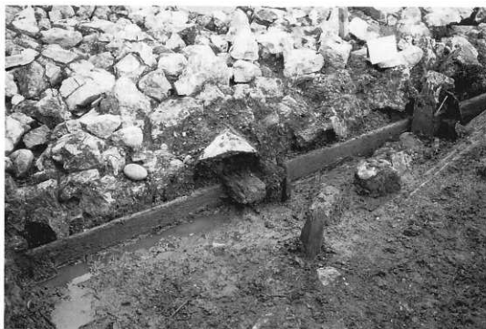
護岸石垣状況
