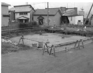
調査区南東側完掘状況 (北→南)
