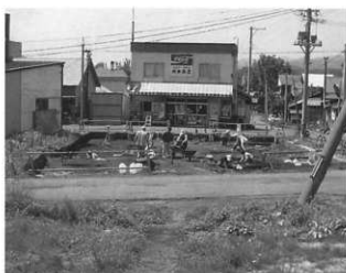
作業風景 (北東→南西)
