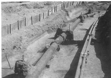
調査区南東側完掘状況 (西→東)
