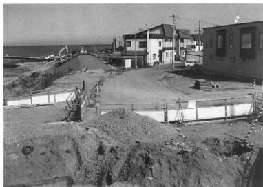
調査区遠景 (南西→北東)
