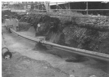
調査区南西側完掘状況 (北西→南東)
