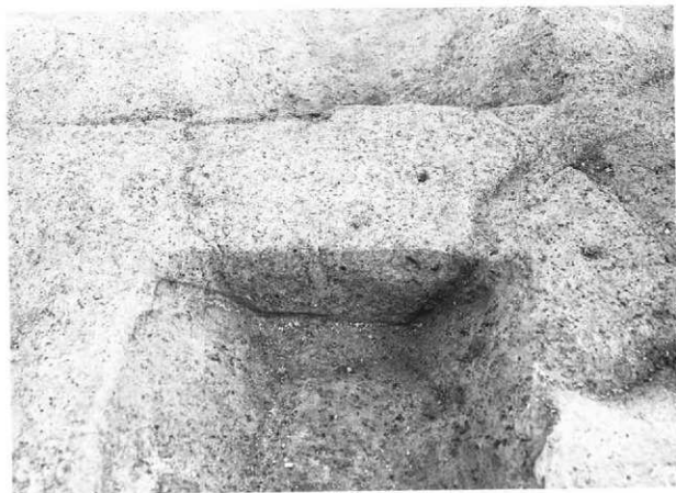
6区 SD05 断面 北から
