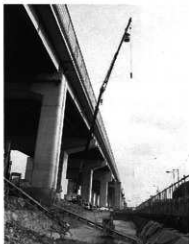
写真1 クレーン撮影風景 (北より)
