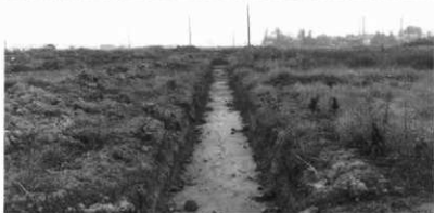
6、部入道地区トレンチの状況
