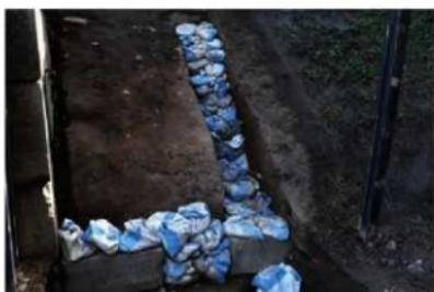
図1-7 造構面土のう養生状況
