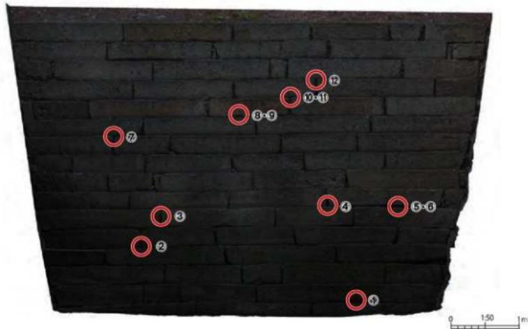
図5-1 東北隅櫓石段スコープ挿入箇所
