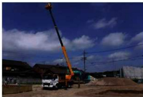
写真11 2地点全景写真撮影(高所作業車)
