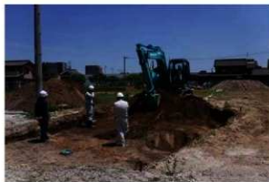
写真7 2地点北半部表土掘削作業
