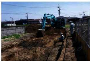
写真3 1地点南半部表土掘削作業
