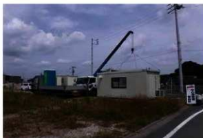
写真2 仮設事務所等設置作業
