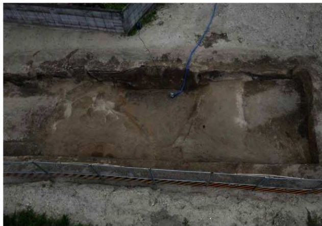
1 1地点南端部（北西から）
