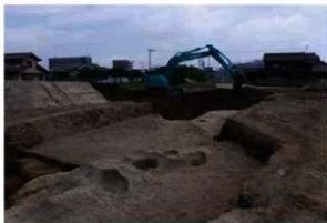
写真12 2地点埋戻し作業
