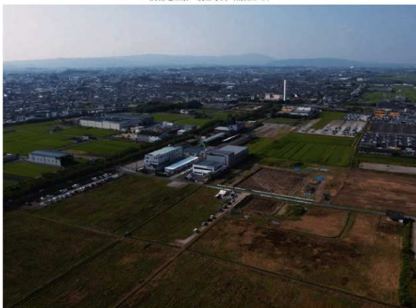
調査地全景 航空写真（南東から）
