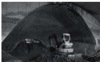
1. 後部の開口部から流入した土砂の除去
