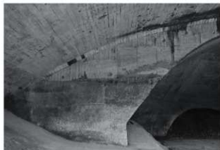
4. 掩体前部奥壁に見える工法の違い 上部がZ6工法、下部がZ5工法
