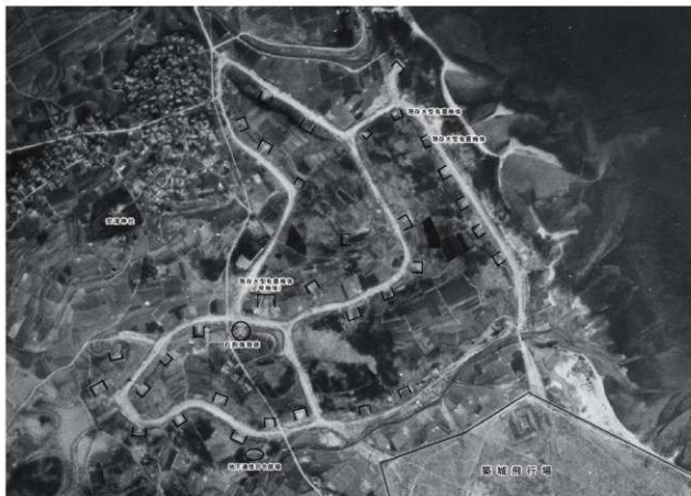
1. 掩体群および誘導路
