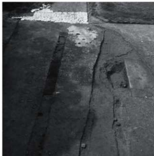
4. 掩体前面の遺構検出状況(北から) 2条の煉瓦敷、爆弾穴、機銃の被弾痕が見える
