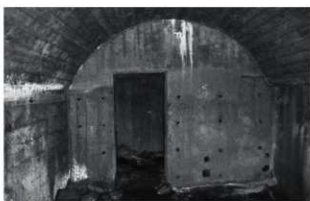
4. 地下通信司令部壕跡(内部)
