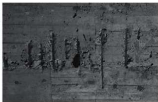
4. 前部天井の鉄筋
