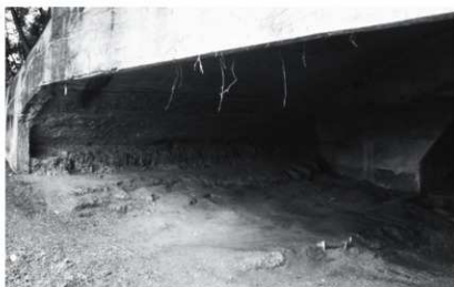
4. 掩体内部の遺構検出状況（西側）
