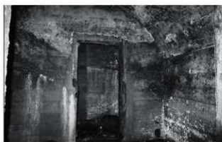
3. 地下通信司令部壕跡(内部)
