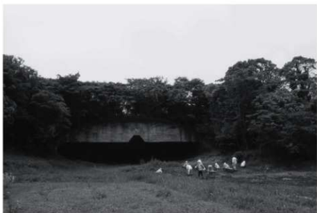
1. 調査開始前の稲童掩体 (除草作業中)
