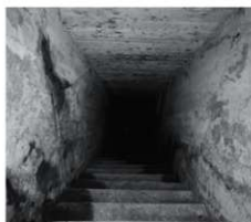
2. 地下通信司令部壕跡(階段)
