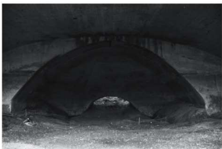
2. 調査前の掩体内(後部を望む) 後部開口部より土砂が流入していた
