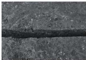
SL29 断面 (南東から)
