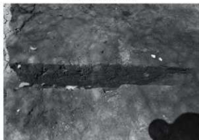
SL05 断面 (南東から)
