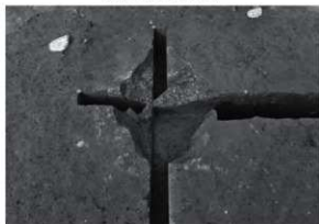
SL28 全景 (南から)
