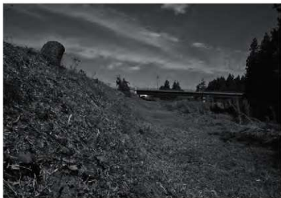
令和元年度斜面部現況（南から）
