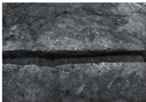
SL32 断面 (東から)
