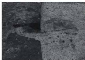
SK08断面 W→
