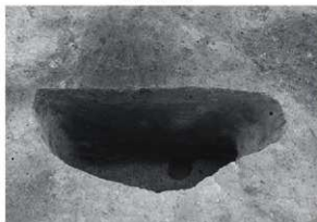
SK22断面 W→
