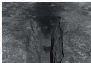
SK31断面 W→
