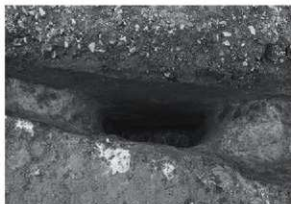
SK50断面全景 S→
