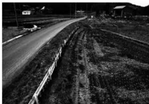
6区 現況 (東から)
