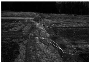
現況 (南東から)
