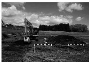
7区 作業風景 (南東から)
