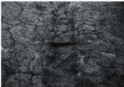
間仕切溝断面 (北から)
