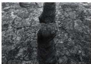
SD05 断面 (南西から)
