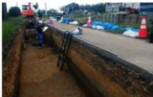
作業風景 (西から)
