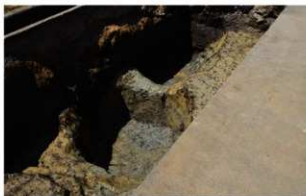
C1区SK31(北から)
