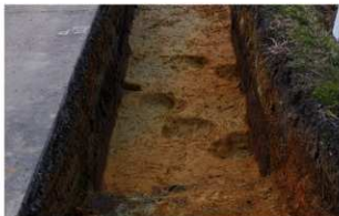
A48・49Pit (東から)
