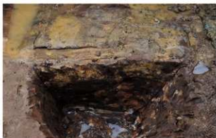
A1区SK1断面(東から)
