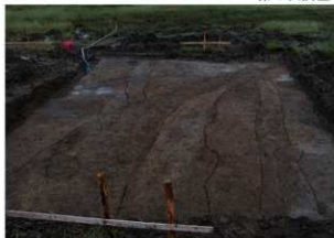
9区遺構検出状況（東から）
