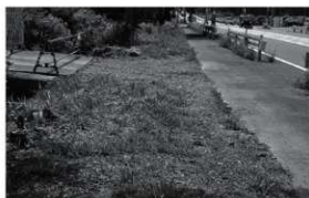
写真3 工事立会箇所全景(北から)
