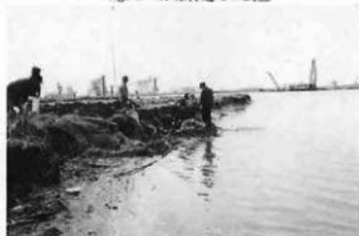
fig. 5 板塀による崩壊防止策
