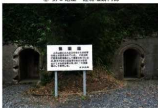
⑤ 第1砲側庫跡 入口
