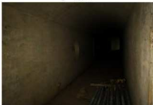
④ 内部通路2
