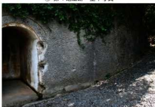
⑥ 第1砲側庫跡 排水孔
