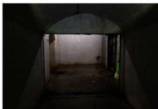
① 連絡通路跡入口金属製扉枠及び鴨居状コンクリート
