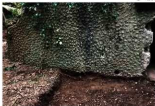
② 排水孔跡及び換気孔跡（外側）
