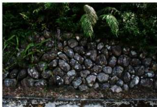
⑤ 円礫による擁壁
