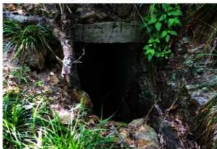
④ 第1観測所跡増築部分入口
