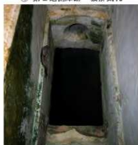
⑥ 第2砲側庫跡 明り取り窓天井部の排気孔
