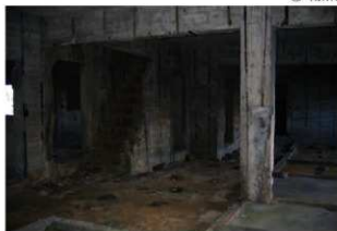
② 衛所跡 1階通路
