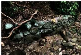
⑤ 第2砲座跡東の排水施設
