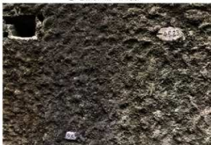
⑤ ドイツ壁表面のコンクリート
