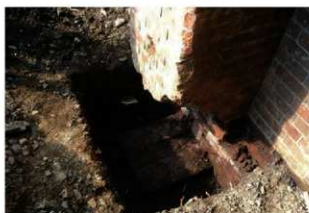
① 水溜跡補強柱内部構造
