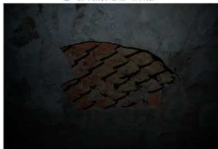
③ 戦闘指揮壕跡内部天井
