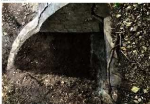
③ 排水砂検出状況
