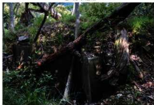
⑤ トーチカ銃跡外観
