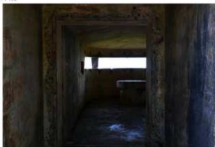
③ 入口の扉跡
