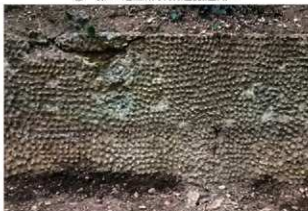
④ 第2砲座跡擁壁ドイツ壁
