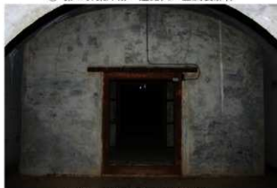
③ 第2弾薬庫跡 内庫前室入口
