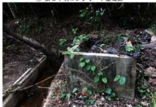
③ コンクリート側溝横のコンクリート桁跡
