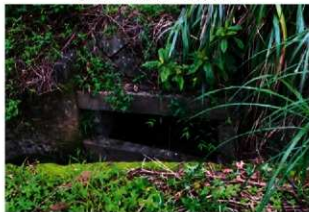
③ 第 1 弾薬庫跡 排水口
