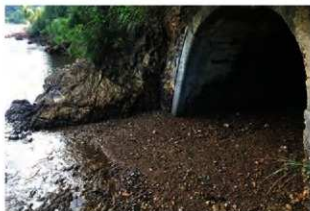
① 第1格納壕跡 入口（満潮時）
