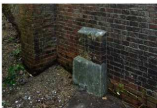
② 水溜跡西壁給水管
