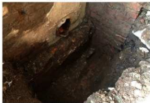
⑤ 水溜跡南側中央拱下部の穴2
