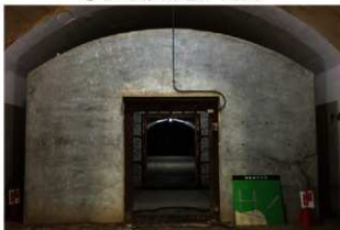
④ 第3弾薬庫跡 内庫前室入口
