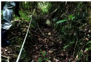
④ 取水口～濾水池の導水路跡
