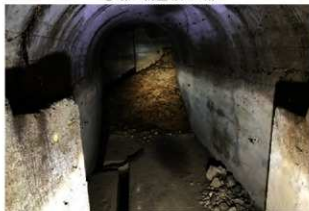
⑤ 第2防空壕跡内部 2
