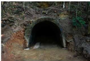
② 第4格納壕跡入口 (発掘調査後)
