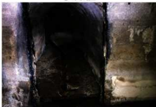
④ 第2防空壕跡内部 1
