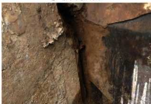
⑤ 擁壁接続部
