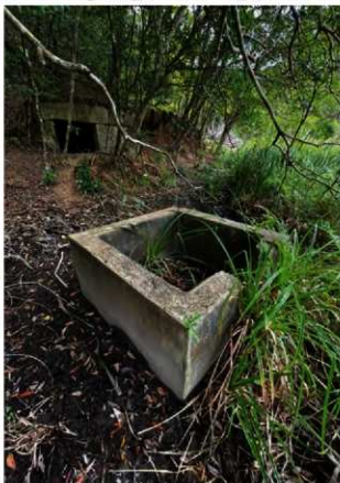
⑦ 第1防空壕跡とコンクリート拵
