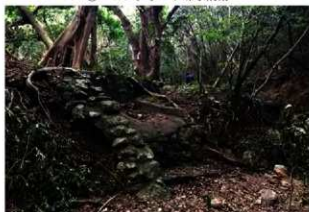
④ 井戸跡排水施設
