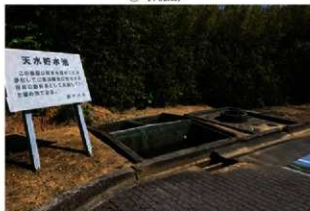
③ 天水貯槽跡
