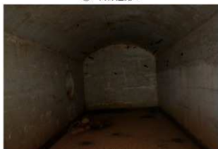
⑤ 弾薬庫跡内部
