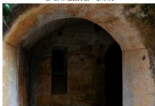
⑤ 第2砲側庫跡 明り取り窓及び弾薬庫入口
