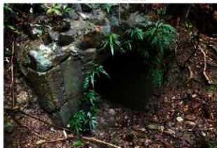
③ 第2防空壕入口跡
