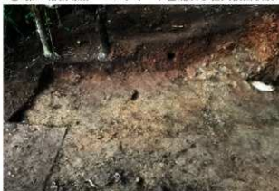
⑥ 第4格納壕跡 岩盤掘削状況
