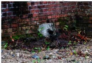
④ 水溜跡南側中央拱下部の穴1
