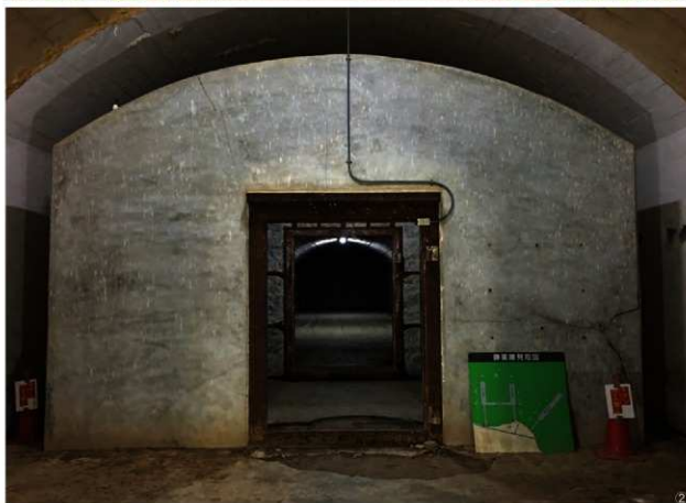
①第3彈藥庫跡入口 ②第3彈藥庫跡前室入口
