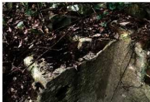
⑤ 濾水池上部鉄筋及び取水管跡
