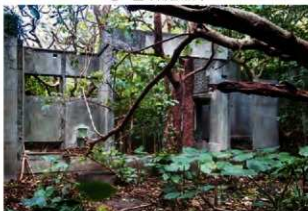
⑥ 監守衛舎跡内部
