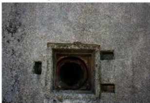
④ 第2砲側庫跡 吸排気孔
