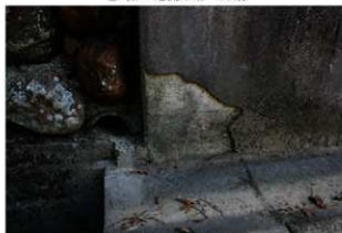
③ 第2砲側庫跡 排水孔
