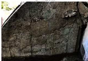
④ 擁壁内面状況
