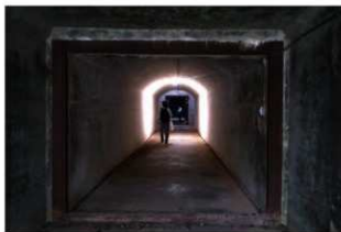
① 第2弾薬庫跡 通路入口金属製扉枠
