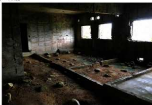
③ 衛所跡 1階居住区
