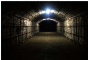
⑥ 第3弾薬庫跡 内庫本室内部構造
