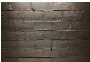
② 連絡通路跡 天井部コンクリートブロック巻き
