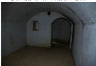
⑧ 第2砲側庫跡 弾薬庫内部
