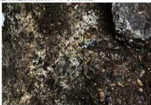
③ 第2砲座跡砲座コンクリート混和剤
