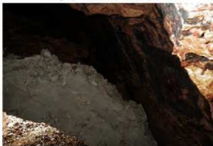
⑥ 第1格納壕跡 坑木
