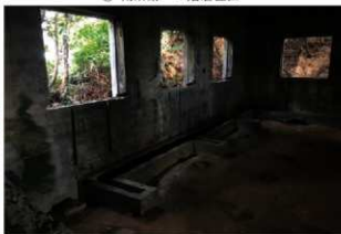
⑤ 衛所跡 配線溝
