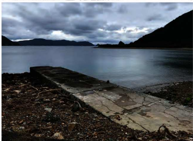
①軍棧橋古写真 「1945/10/6 江仁屋島（江仁屋離）249532」一部改変（米国立公文書館所蔵） ②軍棧橋跡現況
