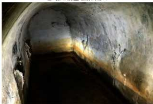
⑥ 第2防空壕跡内部 3
