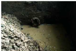
⑦ 濾水池配水管跡
