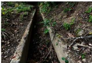
② コンクリート側溝跡
