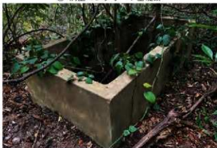
④ 病室と階段の間のコンクリート枡
