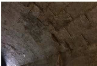
② 第3弾薬庫跡通路 天井部
