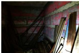
① 衛所 1階蓄電池室跡
