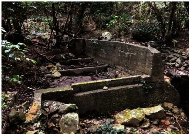
① 沈殿池跡
