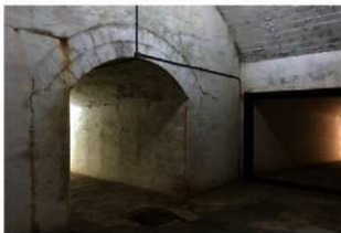
② 第2弾薬庫跡通路 入口上部アーチ構造
