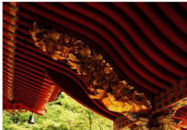
手杖（たばさみ：向拝柱の内側に、屋根の重木勾配に沿って入れられた化粧板）には、金色の八重牡丹と雲が立体的に浮き彫りされている。
