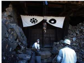
② 崩落石材回収作業 測量等の記録作業後に、回収作業を行います。
