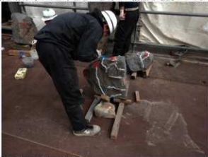
⑥ 築石石材補修作業 割れている石材を接着し、再度積み直しています。
