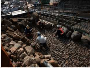
⑦ 積み直し作業（石垣内部構造補強：現代工法） 小天守入口付近の乗込者導線の安全が確保できない箇所のみ、明治時代以降に積み直されている範囲に限り、石垣内部に構造材を敷き込みました。
