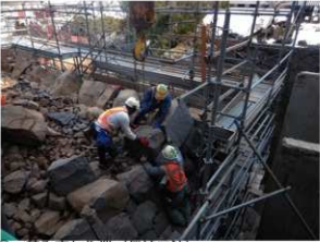
⑧ 積み直し作業（伝統工法） 解体前の写真等を参考に築石を積み上げます。
