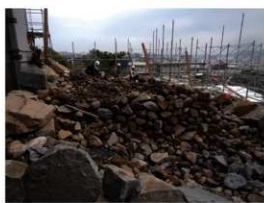
小天守石垣積み直し作業状況
