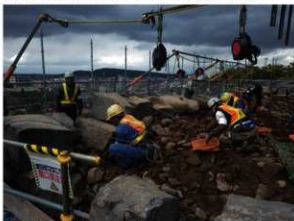
③ 石垣解体作業（裏込め） 一段ごとに回収する築石に合わせて、裏込めを解体します。
