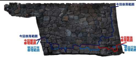
H507 修復履歴図 (復旧完了後)
