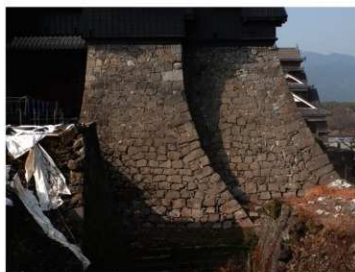
小天守石垣東面 (H509・H511) 復旧完了状況 (東から)
