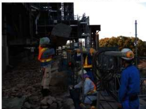
④ 石垣解体作業（築石） 石垣解体時には上下左右の石材との接点を確認します。
