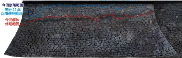
H513 修復履歴図 (復旧完了後)
