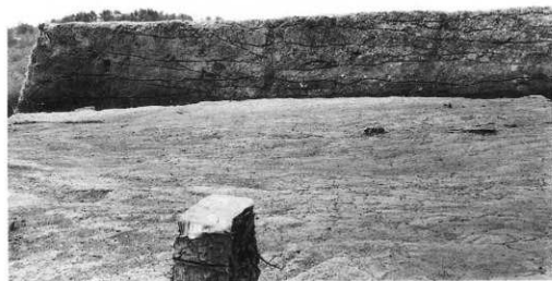
南谷19号墳前方部墳丘 (西側A-A'ベルト) 盛土状況
