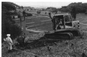
図第6 遺跡重機表土剥ぎ作業
