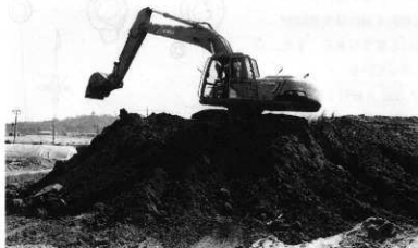
文中写真② 重機表土剥ぎ作業風景
