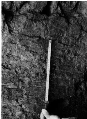
南谷大山遺跡 BSK07工具痕(北西より)
