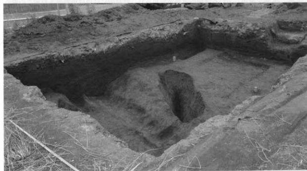
k. 調査完了時 (南より見る)
